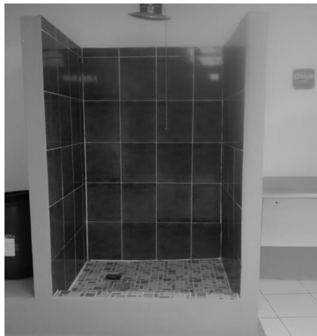
Figura 1. Construcción de ducha de seguridad cumpliendo con requisitos del Informe 32. Fuente: elaboración propia.
